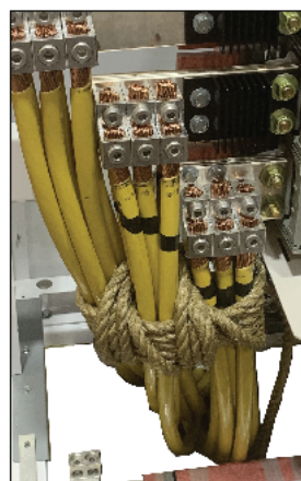
Figure 55 - Exemples d'entrave de câble
