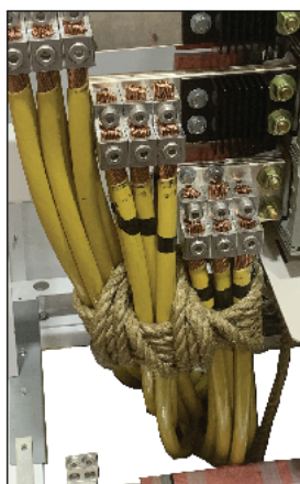
Figure 62 - Exemples d'entrave de câble
