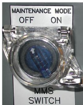
La prueba del sistema MMS debe completarse según se indica en MFR70008. Cuando el interruptor MMS esté encendido (ON), el interruptor automático asociado se establecerá en el «modo de disparo sin retardo intencional» (en la configuración del modo de mantenimiento).
