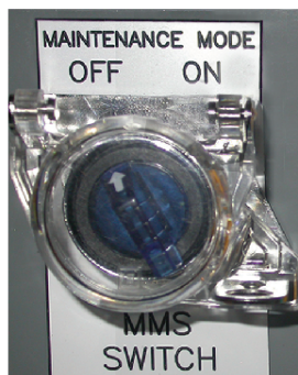
Figura 67 - Conmutador de MMS
