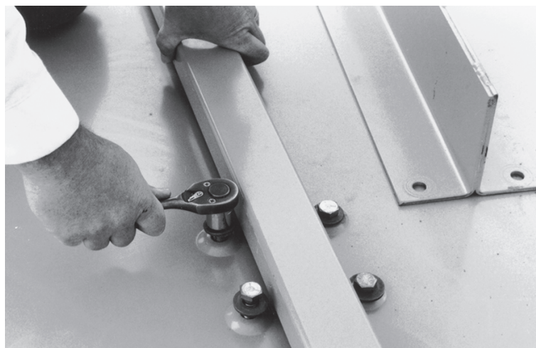
Figure 11 - Obturation des trous avec les boulons et rondelles d'étanchéité
