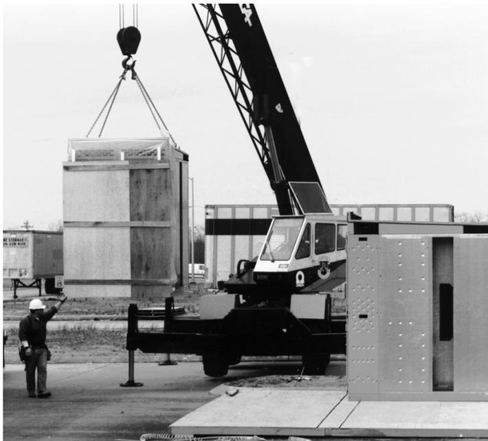
8. Nivele la sección de envío del tablero de fuerza utilizando cuñas de acero si es necesario.
