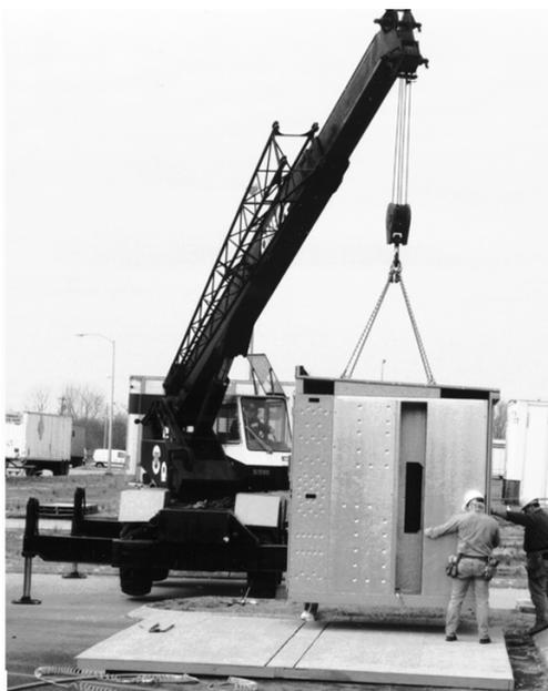
5. Nivele la sección de envío del tablero de fuerza utilizando cuñas de acero si es necesario.
