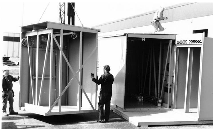
6. À l'aide d'une grue, placer la deuxième section d'allée sur le socle de béton à environ 305 mm (12 po) de la section en place.
