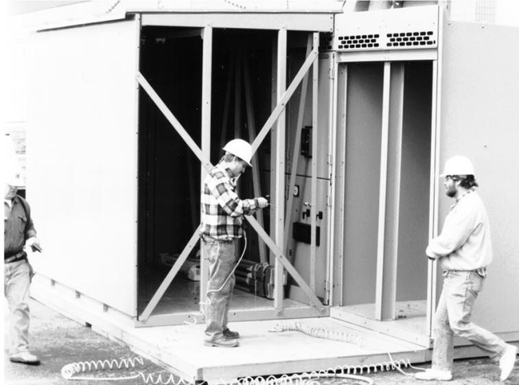
3. Fixer la section d'allée à l'appareillage de commutation en boulonnant le support de toit d'allée de chaque travée à l'avant de l'appareillage de commutation et en boulonnant le toit d'allée au toit de l'appareillage de commutation, à l'aide des boulons de 3/8-16 × 1,0 po fournis (Ancrage du support de toit d'allée sur l'appareillage de commutation, page 27).
