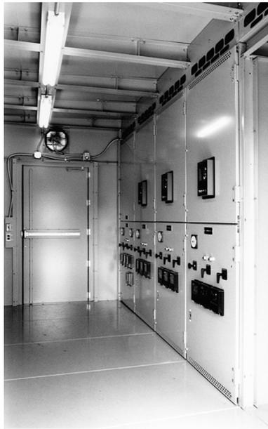
**Figure 30 - Éclairage, chauffage/thermostat (en option)**
