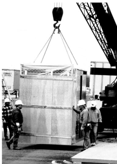
3. Retirer les couvercles de transport. Veiller à ne pas endommager l'instrumentation sur les portes avant en retirant les couvercles d'expédition.
