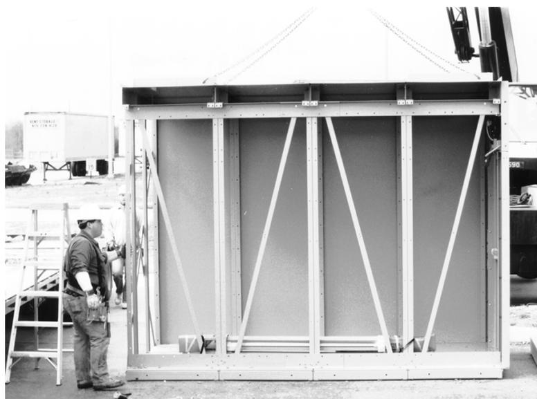
2. Vérifier que les sections verticales, la base et le toit sont alignés avec les sections d'expédition de l'appareillage de commutation. Utiliser des cales en acier si nécessaire. Il est important que les trous de boulon sur les équerres de support du toit d'allée sont alignés avec les trous correspondants à l'avant des sections de l'appareillage de commutation.
