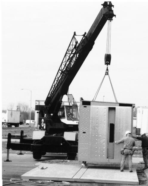
5. Niveler la section d'expédition de l'appareillage de commutation à l'aide des cales d'acier si nécessaire.
