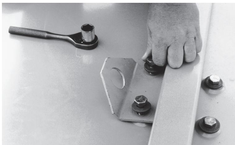
**Figure 10 - Obturation des trous avec les boulons et rondelles d'étanchéité**
