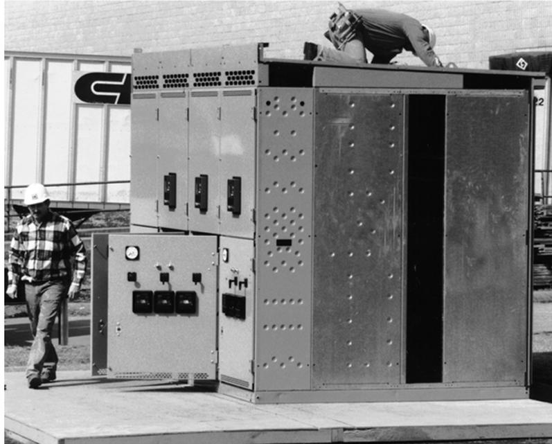
11. Une fois toutes les sections d'appareillage en place et ancrées, fixer les capuchons de toit à l'aide des vis autotaraudeuses de 1/4 po fournies. Voir Installation des capuchons de toit, page 23. Ancrage de l'appareillage de commutation pour applications non sismiques, voir Ancrage de l'équipement pour applications non sismiques, page 25. Ancrage de l'appareillage de commutation pour applications sismiques, voir Ancrage de l'équipement pour applications non sismiques, page 25.
