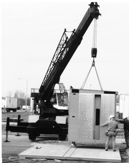
Figura 4 - Colocación de la primera sección
