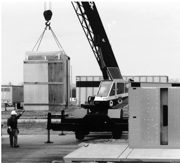
Figura 5 - Descarga de la segunda sección
