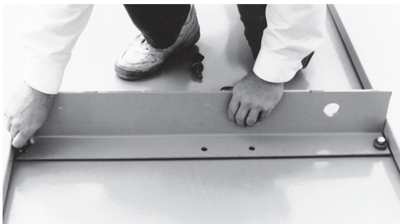
Figura 9 - Extracción de las orejas de izaje pequeñas
