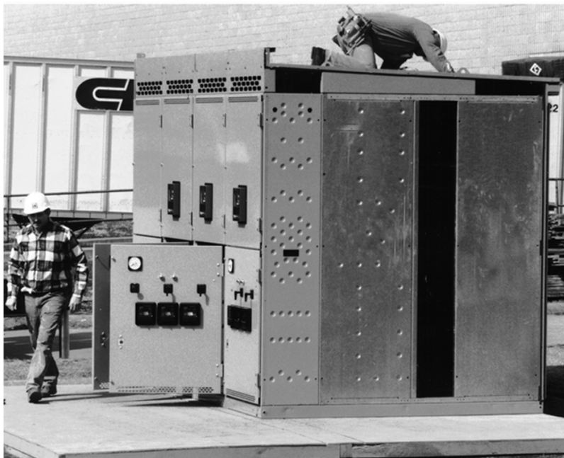
Figura 6 - Fijación de las secciones del tablero de fuerza
