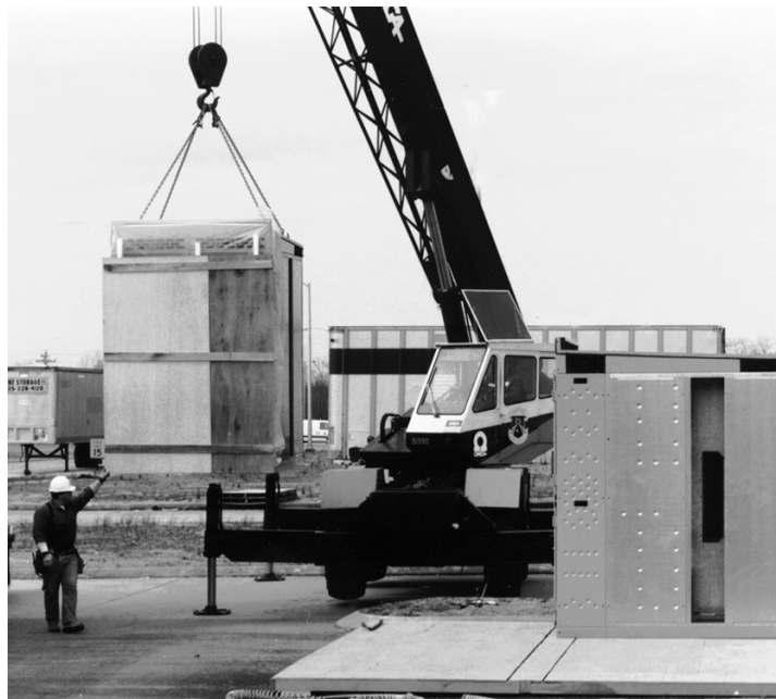
Figure 8 - Déchargement de la deuxième section
