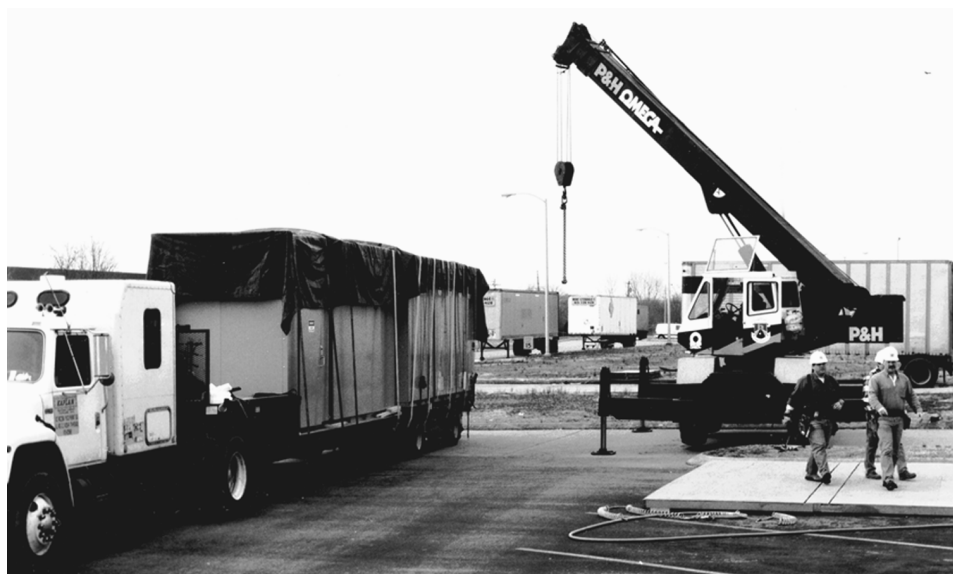
Figure 5 - Préparation au déchargement des sections d'expédition
