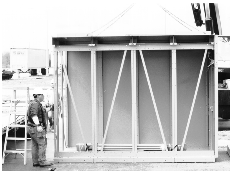
Figure 11 - Section renforcée de l'allée avant
