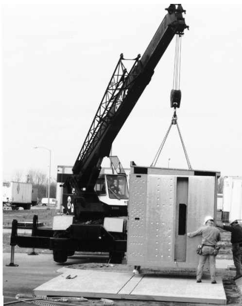
Figure 7 - Positionnement de la première section
