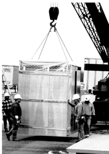
Figure 6 - Déchargement d'une section
