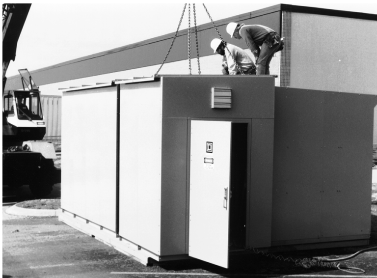
Figure 16 - Placement de la deuxième section d'allée
