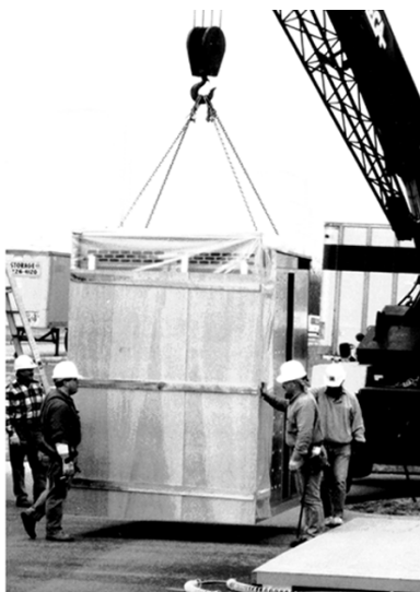
Figura 6 - Descarga de una sección
