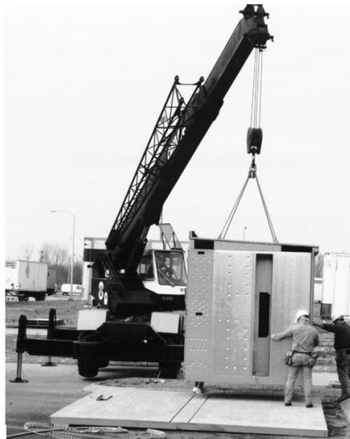
Figura 7 - Colocación de la primera sección
