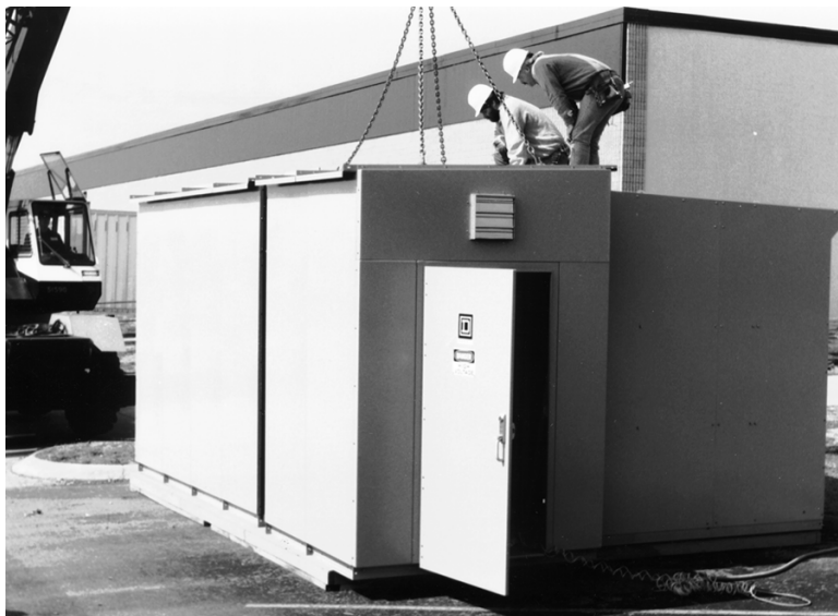
Figura 16 - Colocación de la segunda sección del pasillo
