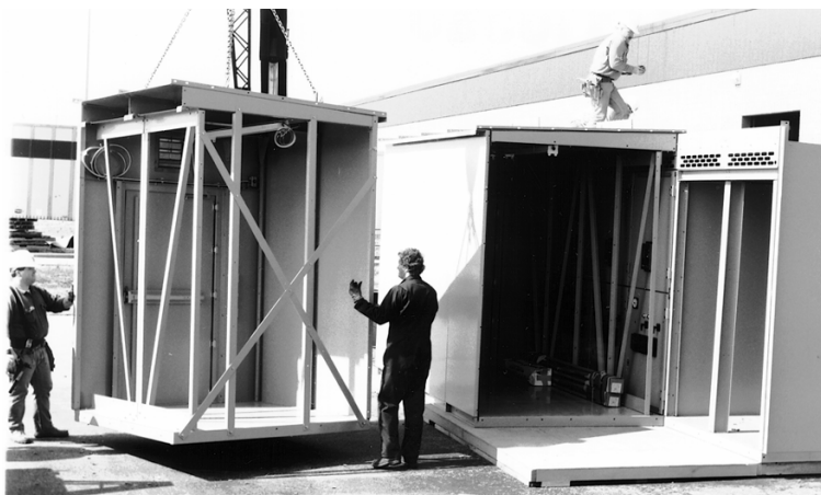
Figura 15 - Movimiento de las secciones con los refuerzos colocados
