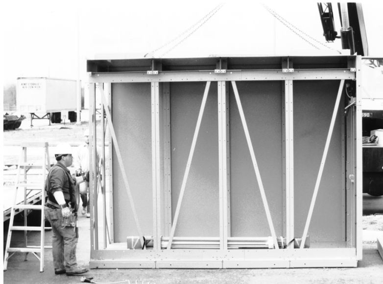
Figura 11 - Sección de pasillo frontal reforzada
