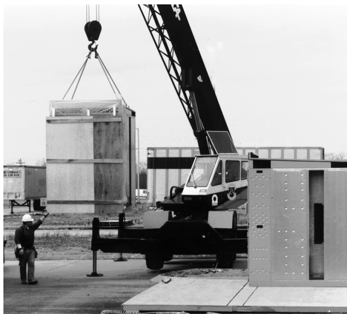
Figura 8 - Descarga de la segunda sección
