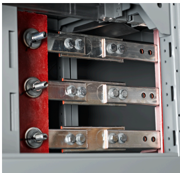
Figure 34 - Application incorrecte de raccordement à barre simple sur une barre-bus de type à fourche
