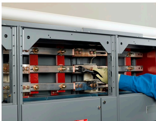
Figure 40 - Retrait des boulons de gauche et desserrage des boulons de droite sur l'ensemble de raccordement
