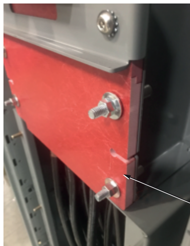
Figure 68 - Couvercle de cosses ArcBlok en place avant le liage
