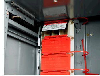
Volet des barres-bus automatique
