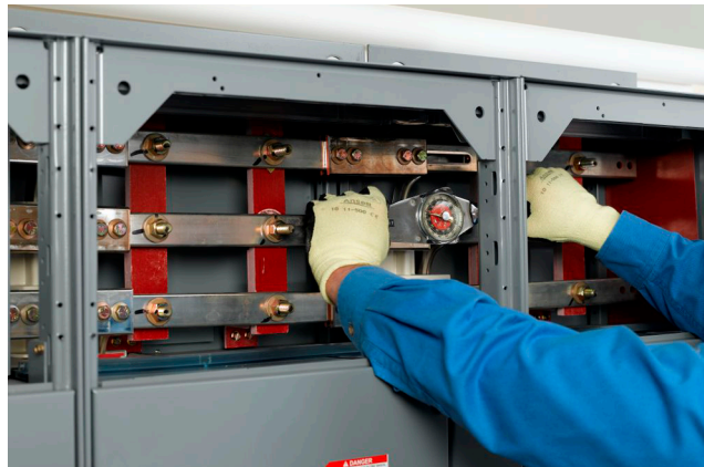
Figure 44 - Serrage des boulons
