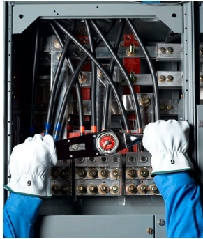
Figure 92 - Couple de serrage des connexions des compartiments des cosses principales
