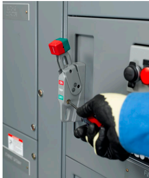
Figure 120 - Manœuvre du mécanisme de neutralisation de l'interverrouillage de porte
