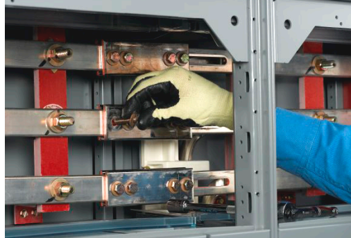
Figure 43 - Mise en place d'une rondelle conique sous la tête du boulon
