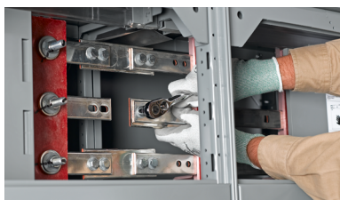
Figure 35 - Retrait des boulons d'une barre à raccordement simple
