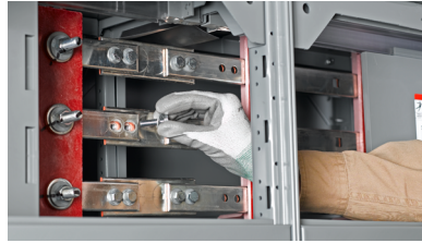
Figure 38 - Mise en place d'une rondelle conique sous la tête du boulon
