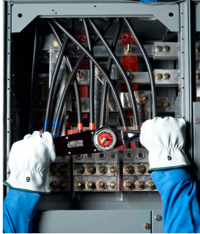
Figure 87 - Couple de serrage des connexions des compartiments des cosses principales
