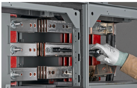
Figure 53 - Retrait des boulons de l'ensemble de raccordement
