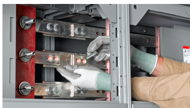
Figure 36 - Déplacement et alignement de la barre de raccordement avec les trous de la barre-bus
