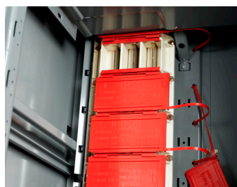
Figure 144 - Retrait de volet manuel des barres-bus
