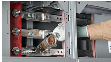
Figure 39 - Serrage des boulons
