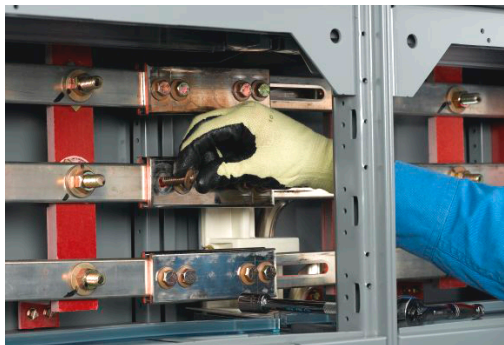
Figure 50 - Mise en place d'une rondelle conique sous la tête du boulon
