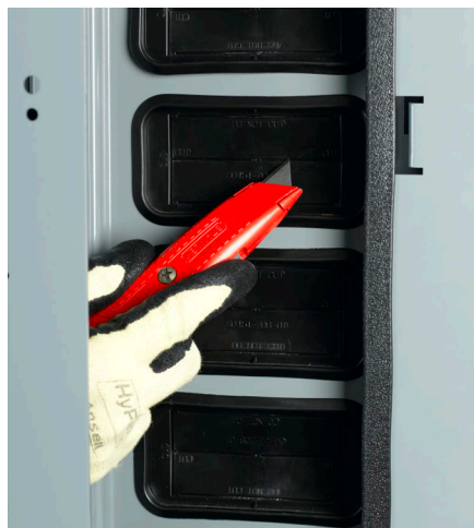
Figure 143 - Découpe du passe-fils en caoutchouc de la goulotte guide-fils verticale (si fourni)
