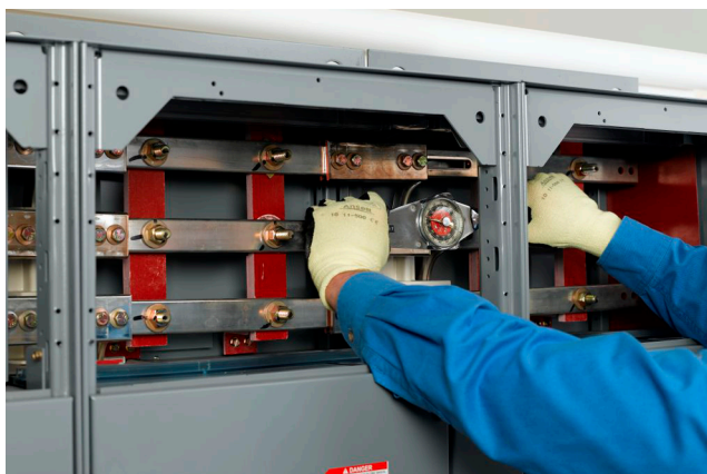
Figure 51 - Serrage de tous les boulons
