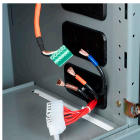
Figure 99 - Conducteurs d'alimentation et dessus des borniers passés par le port de câblage
