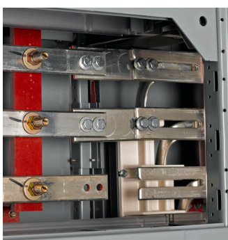
Figure 34 - Application incorrecte de raccordement à barre simple sur une barre-bus de type à fourche
