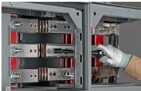
Figura 53 - Extracción de los tornillos del ensamble de empalme
