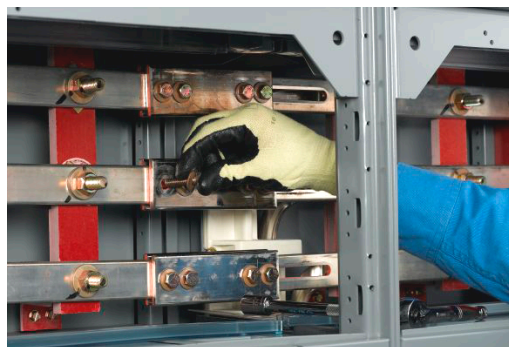
Figura 43 - Cómo colocar una roldana cónica debajo de la cabeza de un tornillo
