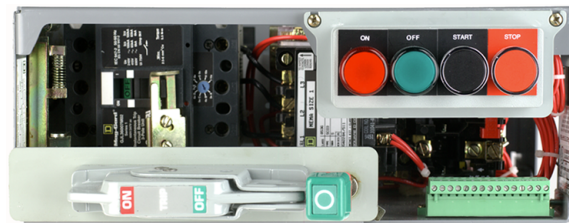
Figura 123 - Unidad estándar con clasificación NEMA
