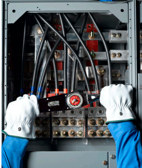
Figura 87 - Conexión de torsión en el compartimiento de zapatas principales
