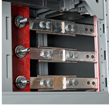
Figura 34 - Aplicación incorrecta de empalme de una sola barra en una barra tipo horquilla
