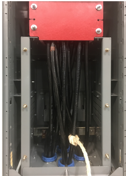
Figura 69 - Primer bucle de sujeción de cables
