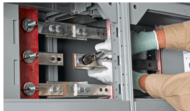
Figura 35 - Extracción de los tornillos de las barras de empalme sencilla
