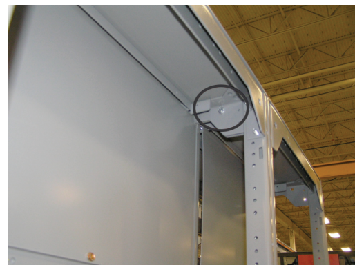
Vista G: Conexión del canal lateral trasero superior (se muestra sin las placas posteriores del CCM).
