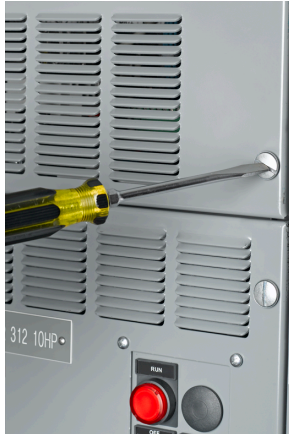
Figura 95 - Aflojamiento de sujetadores cautivos
