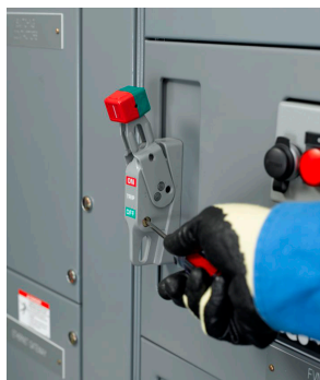
Figura 120 - Operación del mecanismo de desactivación del enclavamiento de la puerta
