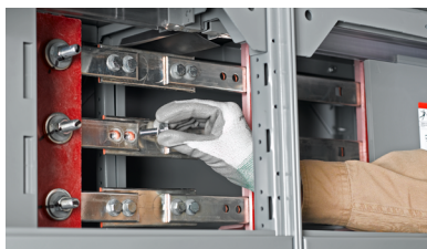
Figura 38 - Cómo colocar una roldana cónica debajo de la cabeza de un tornillo
