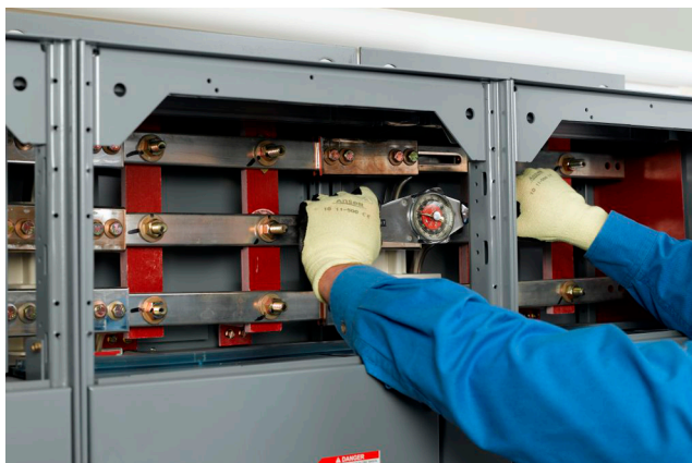
Figura 51 - Apriete de los tornillos
