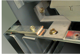
Figura 61 - Recolocación del tornillo de las barras de tierra
