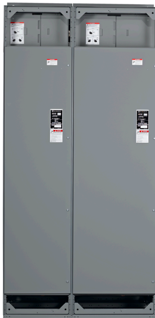
Vista B: Sin las cubiertas del canal de cables horizontal
