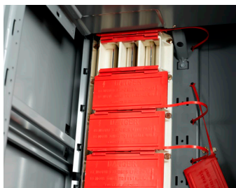
Figura 144 - Desmontaje de la persiana manual de las barras
