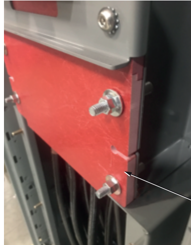
Figura 68 - Cubierta de la zapata del ArcBlok colocada antes de la sujeción
