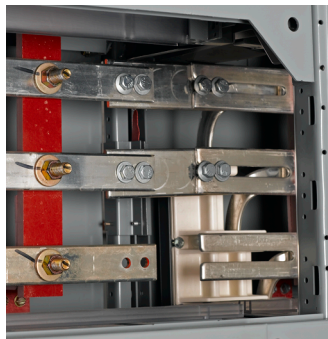
Figura 34 - Aplicación incorrecta de empalme de una sola barra en una barra tipo horquilla
