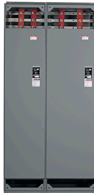
Vista C: Sin las barreras de las barras de dos piezas (conexión de empalme hecha)
