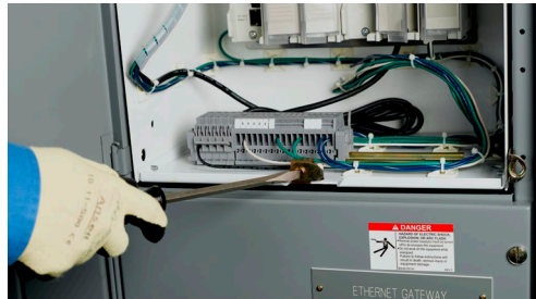
Figura 97 - Liberación del dispositivo de bloqueo (cuando se suministra)
