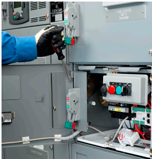
Figura 105 - Extracción del pasador de la bisagra
