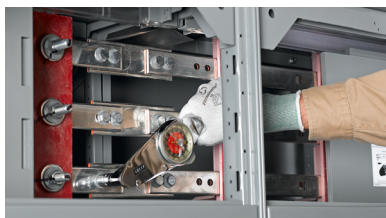
Figura 39 - Apriete de los tornillos
