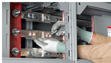
Figura 36 - Desplazamiento y alineación de las barras de empalme en los agujeros de las barras
