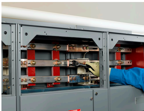
Figura 40 - Extracción de los tornillos izquierdos y afloje de los tornillos derechos en el ensamble de empalme
