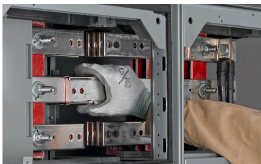
Figura 48 - Deslizamiento del ensamble de empalme hacia la izquierda
