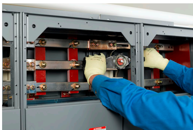
Figura 44 - Apriete de los tornillos
