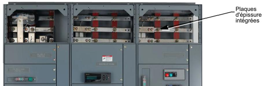
3. Repérer les plaques de raccordement intégrées. Les plaques de raccordement sont généralement situées à l'extrémité gauche du bus principal du CCM dans chaque section d'expédition. Dans certaines constructions, la pièce de raccordement peut être incluse sous forme de kit dans un carton et fixée à l'intérieur de la structure du CCM.
