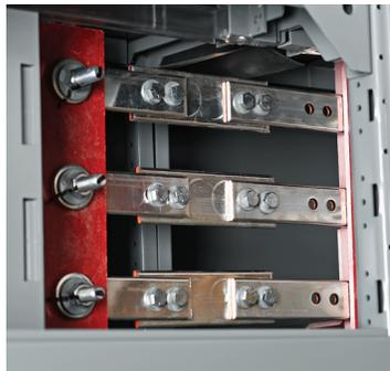
**Figure 12 - Application incorrecte de raccordement à barre simple sur une barre-bus de type à fourche**
