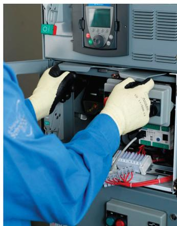
9. L'interverrouillage entre le mécanisme et la structure empêche le retrait ou l'insertion de l'unité de contrôle avec la manette sur la position de marche (voir Manœuvre de l'interverrouillage entre le mécanisme et la structure, page 73).
