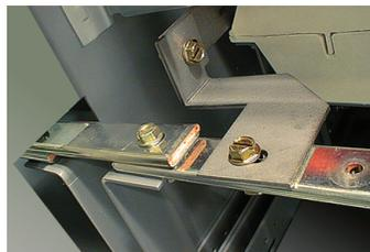
4. Remplacer les boulons de la barre-bus de mise à la terre (voir Type 1, type 12 et type 3R, page 37) des sections de droite et de gauche. Serrer les deux boulons au couple de serrage de 60 à 75 lb-po (6,75 à 8,44 Nm).
