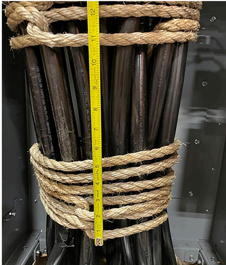
8. Une fois l'ensemble du faisceau de câbles lié, attacher fermement l'extrémité de la corde aux groupes de boucles, puis couper et fixer l'extrémité avec du ruban adhésif pour éviter qu'elle ne s'effiloche. S'assurer que la corde n'obstrue pas le capot avant du compartiment de câbles, le câblage du commutateur de déconnexion de fusible ou le poussoir d'indicateur d'événement ArcBlok.
