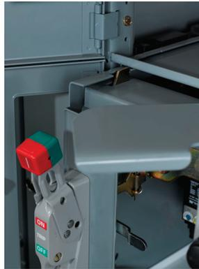
10. Si l'unité retirée est laissée dans la structure, utiliser les procédures de verrouillage appropriées pour éviter sa réinsertion par un personnel non autorisé (voir Unité verrouillée, page 73).
