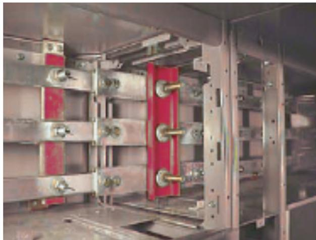
2. Faire glisser la pièce de raccordement vers la gauche jusqu'à ce que les deux trous de gauche soient alignés avec les trous correspondants dans la barre-bus horizontale de la section de gauche.
