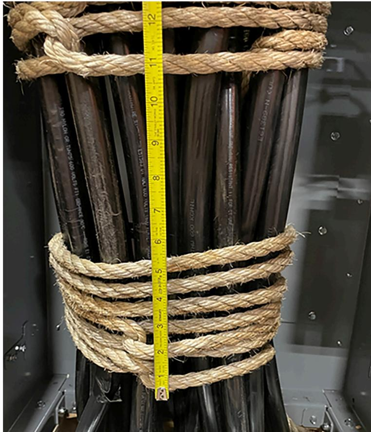
8. Después de haber sujetado todo el manajo de cables, ate el extremo de la cuerda firmemente a los grupos de bucles, luego corte y pegue con cinta adhesiva el extremo para evitar que se deshilache. Asegúrese de que la cuerda no obstruya la cubierta delantera de la cámara de cables, el cableado del interruptor de desconexión de fusibles o el émbolo indicador de evento del ArcBlok.
