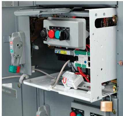
11. Retire la unidad de control de la estructura para realizarle servicio. En las unidades que contienen una placa inferior entera, es posible obtener acceso adicional a los componentes y cables plegando la placa inferior hacia abajo. Para eso, apoye la unidad sobre su parte trasera, retire los dos tornillos del frente y pliegue la placa inferior hacia abajo (consulte Unidad de control con la placa inferior de la plegada hacia abajo, página 73).
