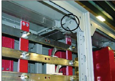
**C** Conexión del canal lateral superior
