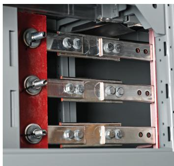
**Figura 12 - Aplicación incorrecta de empalme de una sola barra en una barra tipo horquilla**
