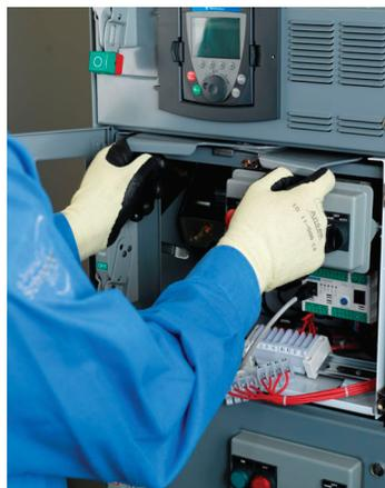
9. El enclavamiento entre el automatismo y la estructura impide la extracción o inserción de la unidad de control con la palanca en posición ON (consulte Funcionamiento del enclavamiento del mecanismo a la estructura, página 72).
