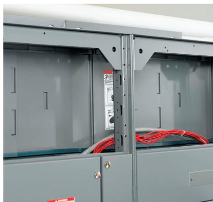
Los cables de control y de alimentación se dirigen a cada unidad a través del canal de cables vertical. Los orificios para cables con ojal aislante (si viene provisto con ellas) deben cortarse para dirigir los cables a la unidad. El patrón de corte en forma de H viene previamente ranurado para facilitar su apertura. Con una navaja pequeña, corte por el centro de las lengüetas y complete la sección en forma de H. Al cortar, asegúrese de no dañar los cables ubicados cerca de la placa protectora.
