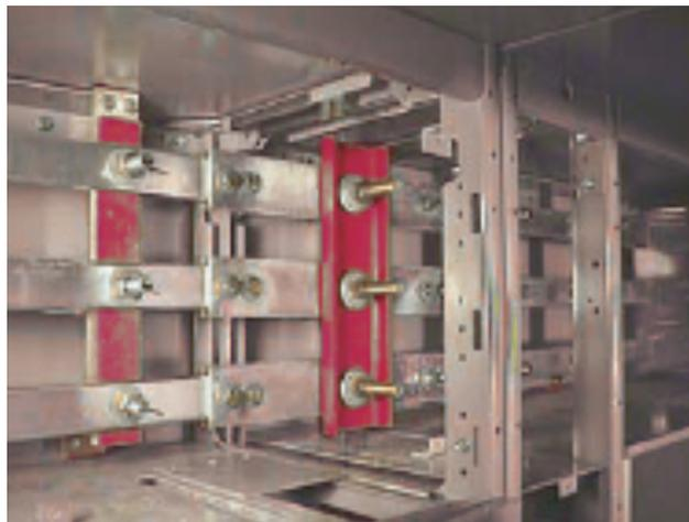
2. Deslice el ensamble de empalme hacia la izquierda hasta que los dos orificios izquierdos estén alineados con los orificios correspondientes en la barra horizontal en la sección izquierda.
