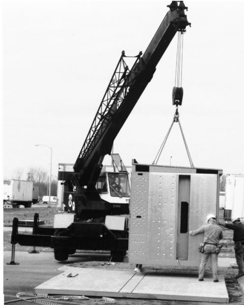
5. Nivele la sección de transporte del tablero de fuerza utilizando cuñas de acero si es necesario.
