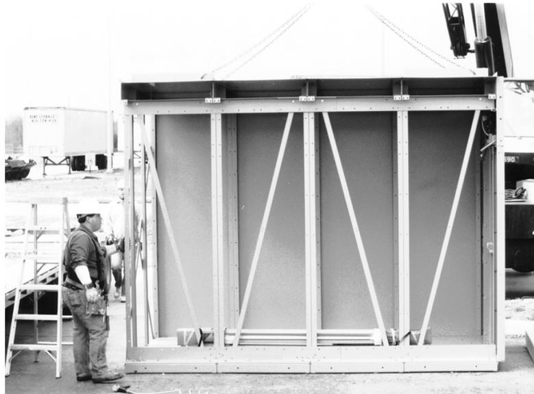
2. Verifique que las secciones verticales, la base y el techo estén alineados con las secciones de transporte del tablero de fuerza. Utilice espaciadores de acero si es necesario. Es importante que los orificios de los pernos de los soportes del techo del pasillo se alineen con los orificios correspondientes en la parte delantera de las secciones del tablero de fuerza.
