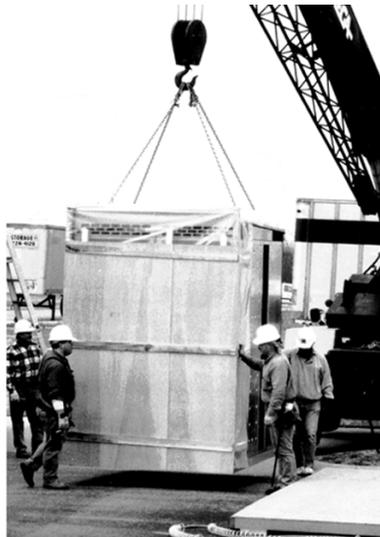
3. Quite las cubiertas de transporte. Tenga cuidado de no dañar la instrumentación de las puertas delanteras cuando quite las cubiertas del transporte.
