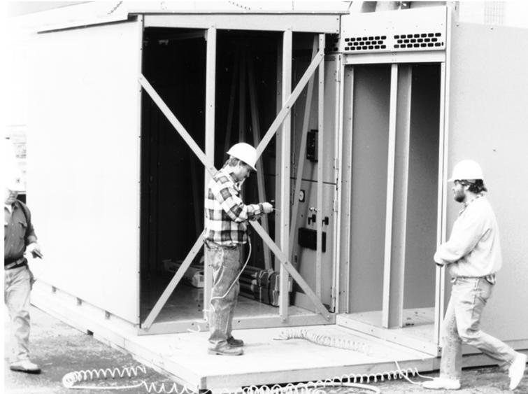
3. Fije la sección del pasillo al tablero de fuerza atornillando el soporte del techo del pasillo de cada nave a la parte delantera del tablero de fuerza y el techo del pasillo al techo del tablero de fuerza utilizando los pernos de 3/8-16 x 1.0 pulg suministrados (Anclaje del soporte del techo del pasillo al equipo del tablero de fuerza, página 25).
