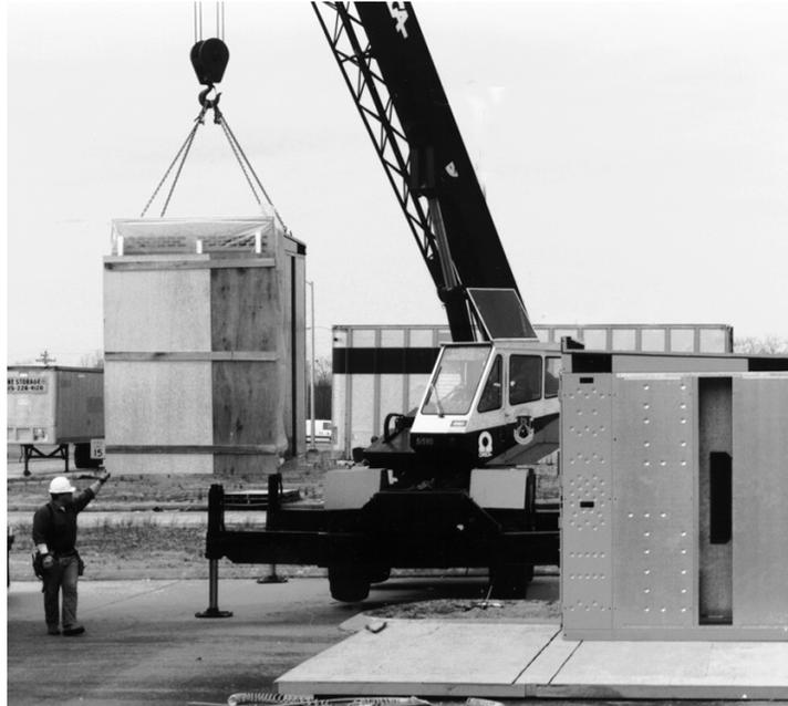
8. Nivele la sección de transporte del tablero de fuerza utilizando cuñas de acero si es necesario.
