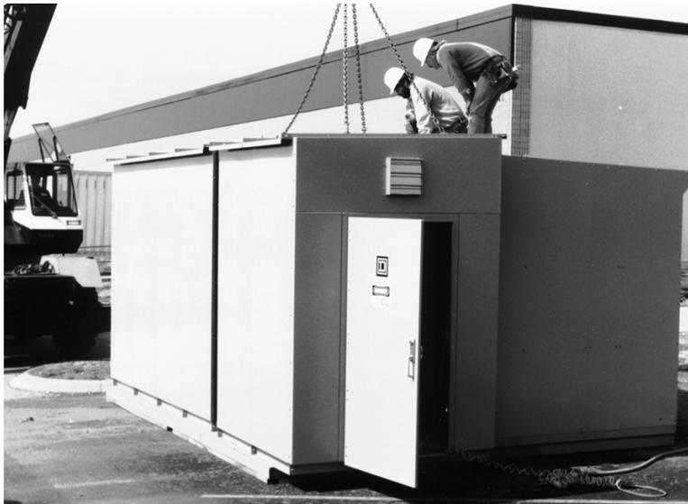
8. Instale, nivele y fije la segunda sección del pasillo al tablero de fuerza atornillando el refuerzo de soporte del techo del pasillo de cada bastidor a la parte delantera del tablero de fuerza y atornille el techo del pasillo al techo del tablero de fuerza. Utilice espaciadores de acero, si es necesario, para garantizar una buena alineación.
