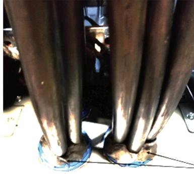
Tubos conduit en la placa de cierre de tubos conduit extraíble sellados con sello para conductos.
