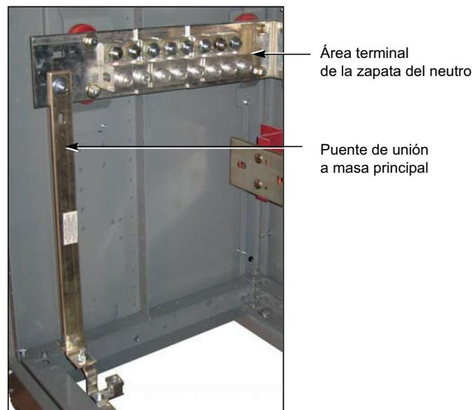
En Canadá, se proporciona una barra de distribución o un cable puente de unión a masa principal entre la barra del neutro y la barra de puesta a tierra. Cuando se deba desconectar el puente de conexión a masa (por ejemplo, para una prueba Megger®):
